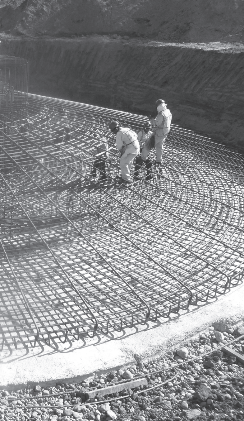
Base de aerogenerador, Foto: CODIGO DH
